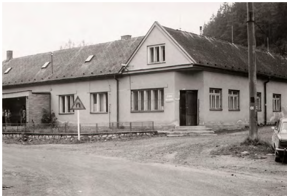
Fotografie domu čp. 28 v roce 1990
